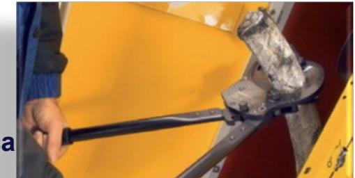
Ручным гидравлическим кабелерезом он сможет выполнить 15-20 резов. В таком режиме можно проработать несколько часов
