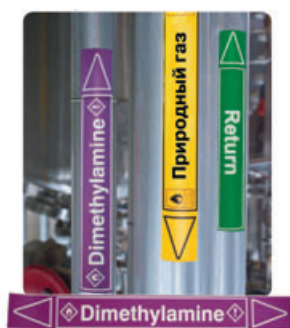
Маркировка трубопровода
